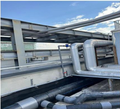
回收水供应至废气洗涤塔
